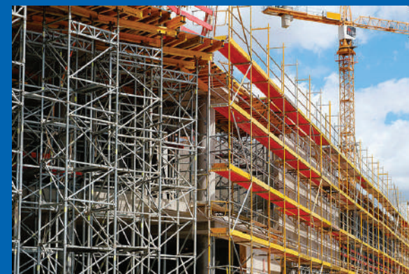
Formation échafaudage roulant
